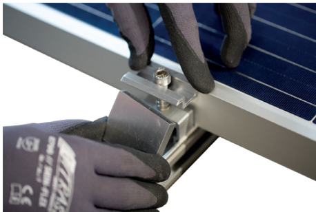
Modulbefestigung: Mittelklemmen-Set + Ausgleichsprofil
