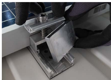
Modulbefestigung: Mittelklemmen-Set + Ausgleichsprofil
