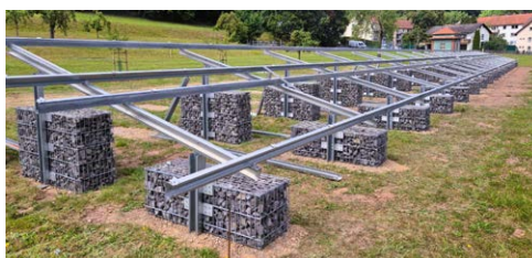
Vielfältige Systemvarianten: Rammung, Aufdübeln auf Betonfundamente, Gabionenanbindung
