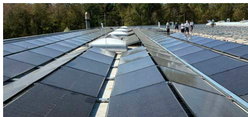
Kombination von Ost-West- und Süd-Aufständern für optimale Flächennutzung
