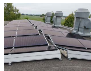
Abbrutschsicherung bei Neigungen \geq 3^\circ Grad
