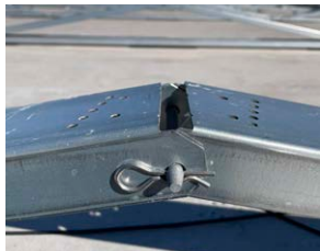
Werkzeug- und spanlos durch innovatives Steckbolzensystem
